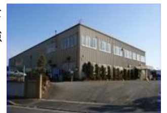
本社工場の外観
