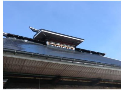
写真④屋根の内側
